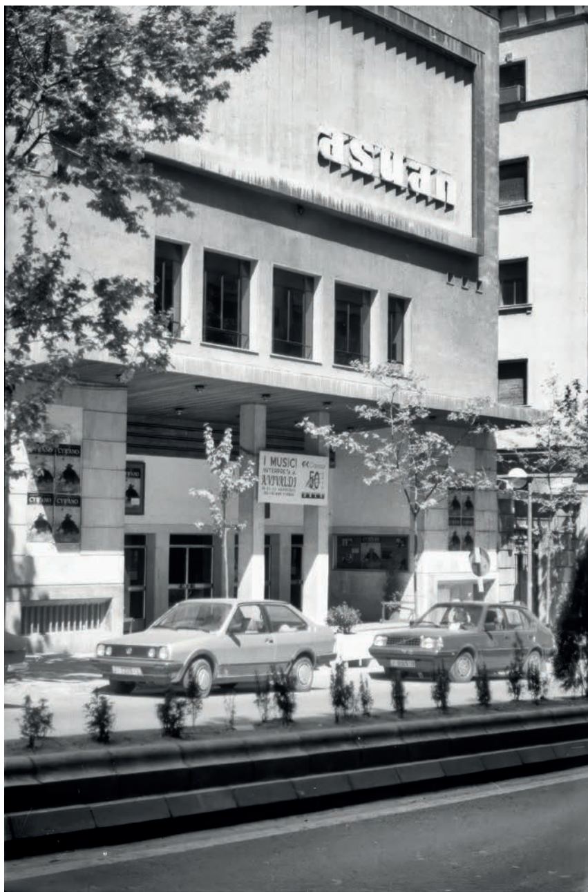
El teatro Asuán, inaugurado en 1966 y demolido en 2001
